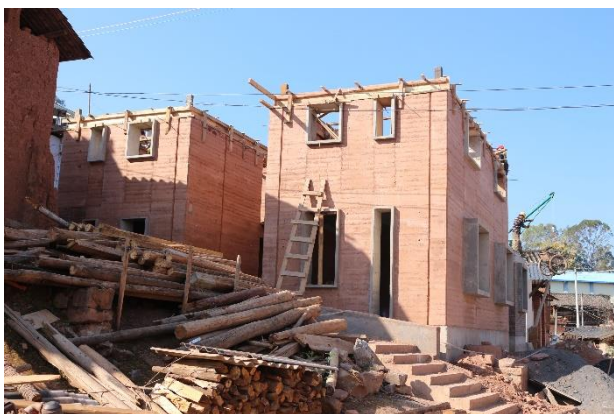
李忠蘭家二層土牆完成
